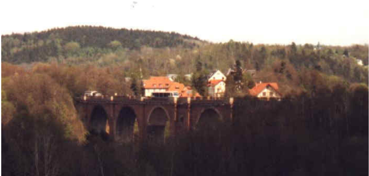
Elstertalbrücke von Röttis aus
